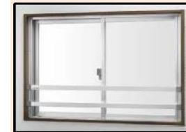
転落防止の手すりの設置
